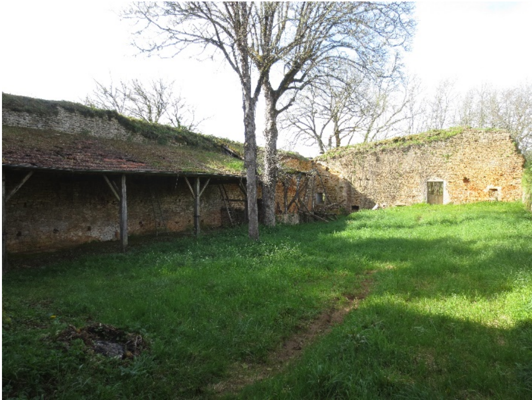
Ci-dessus, intérieur du mur Sud, ci-dessous, intérieur du mur Ouest.
