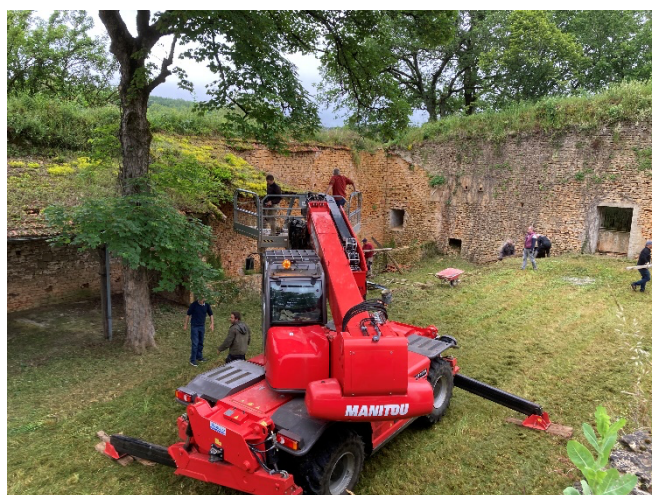
Déconstruction d'une toiture au sein de la ruine forteresse.
