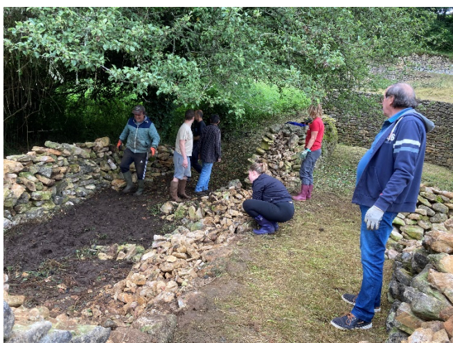
Démontage d'un mur écroulé près du ruisseau,
