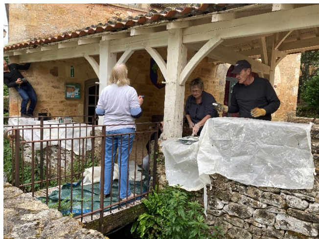
Travaux de peinture ,
